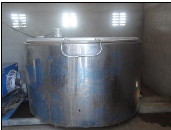
Figura 58 – Tanque em local fechado sem azulejos
