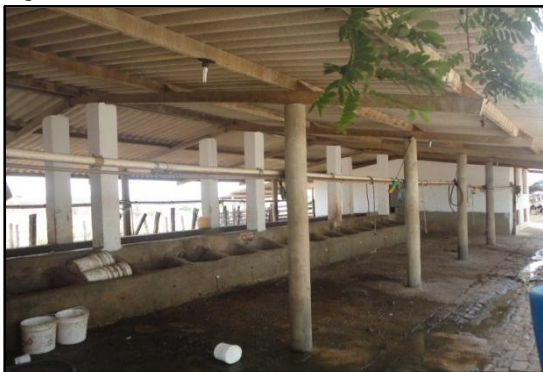
Figura 50 – Telha de fibrocimento
