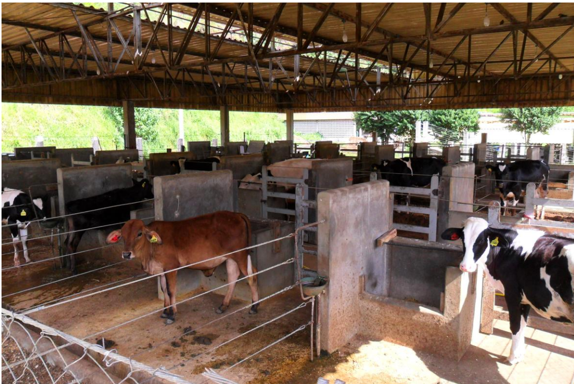
Figura 3- Bezerreiro de alvenaria.
