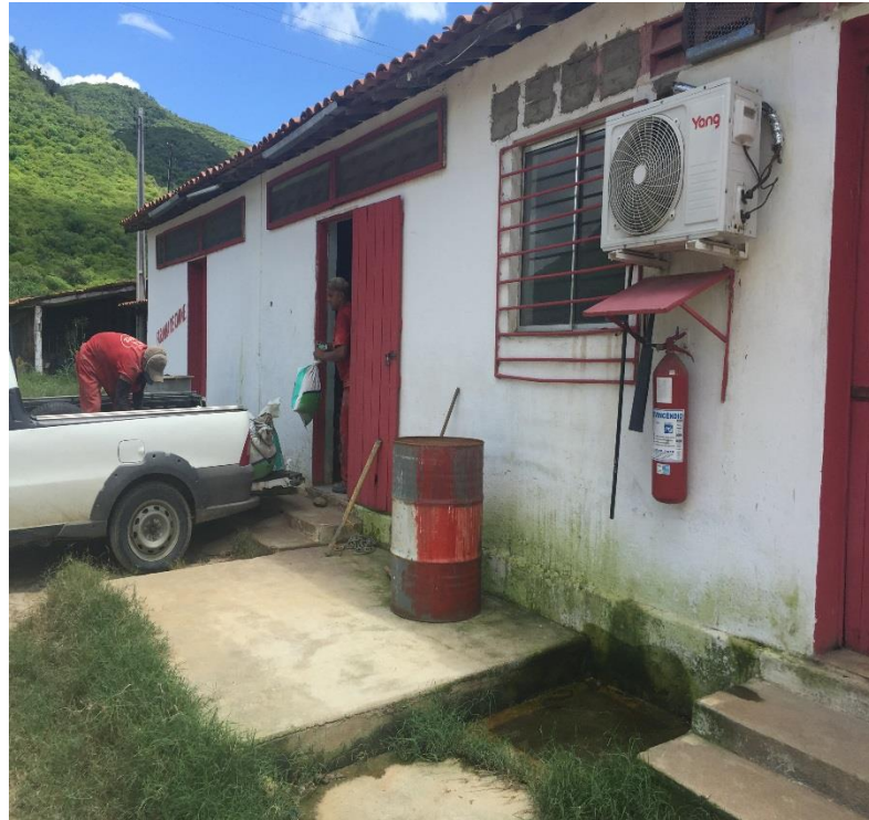
Figura 7 – Sala climatizada para o preparo de premix
