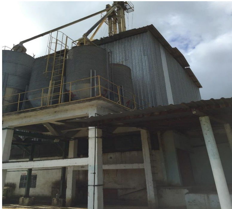
Figura 9 – Ala de armazenamento e carregamento da ração pronta na Fábrica I
