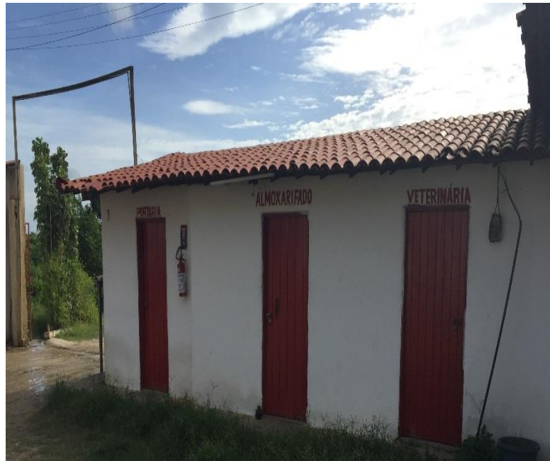
Figura 14 – Portaria, almoxarifado e sala para veterinários da Fábrica I
