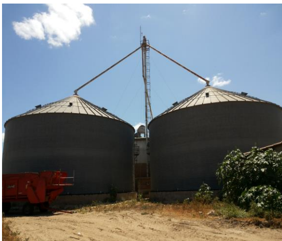
Figura 26: Silos para armazenamento de grãos.
