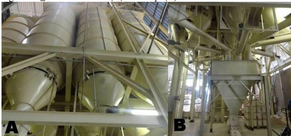
Figura 25 _ Silos dosadores (A) e balança (B)
