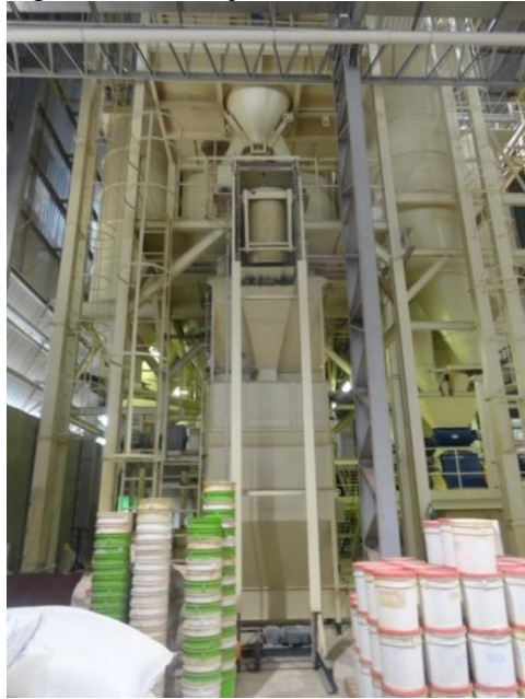
Figura 26 _ Conjunto de caixas
