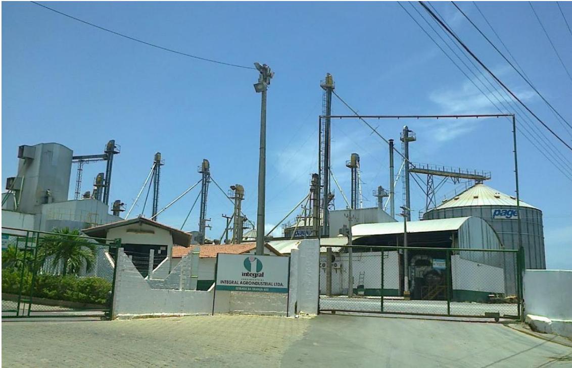
Figura 1 - Vista externa geral da fábrica Integral Agroindustrial Ltda, Unidade Industrial de Fortaleza-CE.
