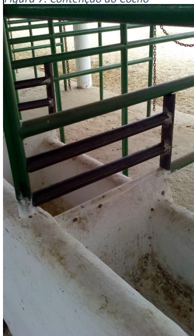
Figura 7: Contenção do Cocho
