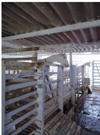
Figura 13: Baias de piso suspenso
